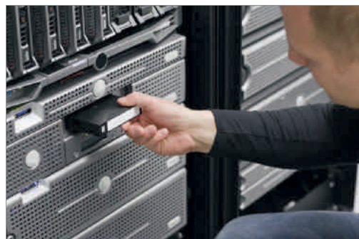
Ein Mitarbeiter legt ein Sicherungsband ein
